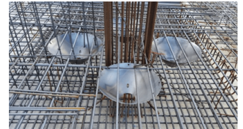
※ MSP (Multiple Shear Preventer) 공법 기초에 전달되는 기둥 하중을 분산하여 기초 두께를 줄일 수 있는 공법 빌리브 스카이외 다수의 주거 현장, 스타필드 고양, 대전 사이언스 콤플렉스 현장 적용
