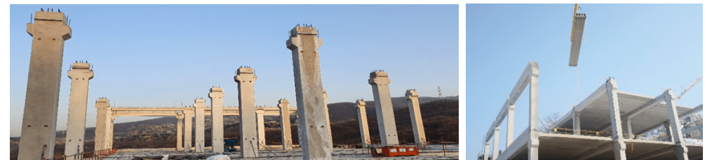
※ OSC (Off Site Construction): 광주오포 물류, 화성 물류센터 적용
