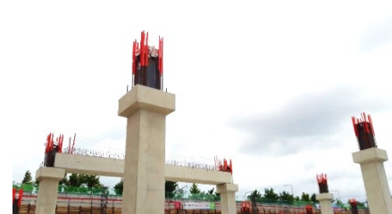
※ HPC (Hybrid PC 기둥) 공법 각형강관의 두께를 최소화하여 기둥의 중량을 감소시키고 보의 구조재료의 종류에 상관없이 접합부 시공 가능한 공법 월계 트레이더스, 김포 물류센터 현장 등 적용
